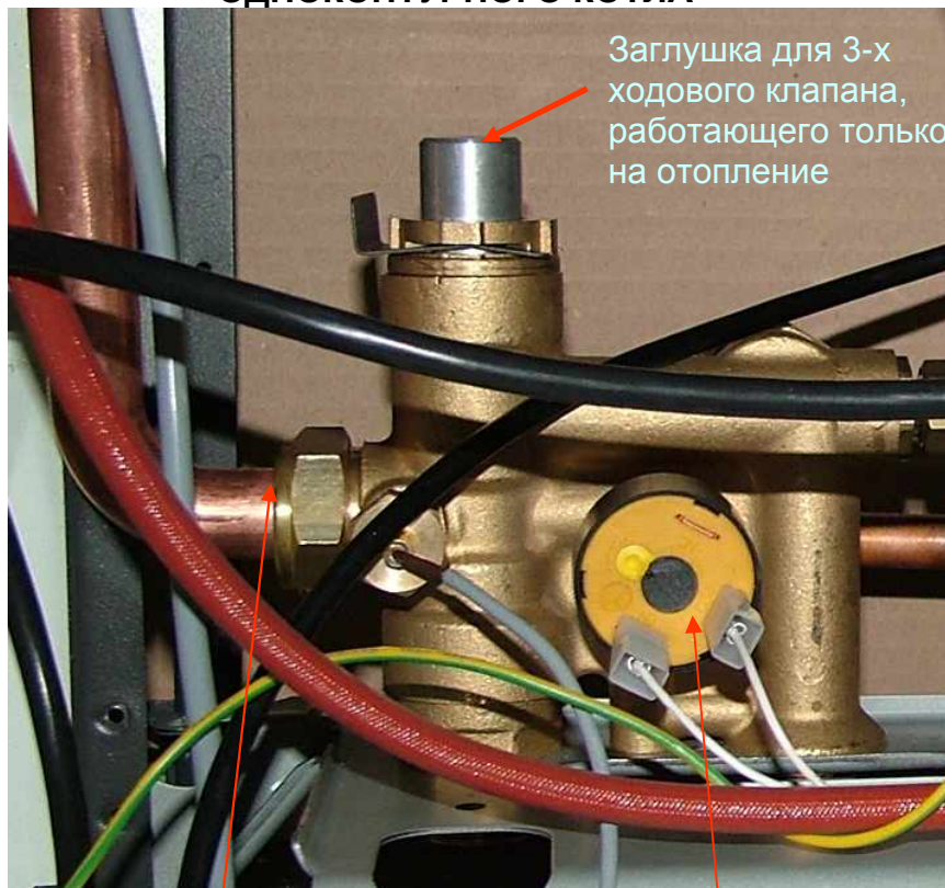
Подсоединение трубы подачи
